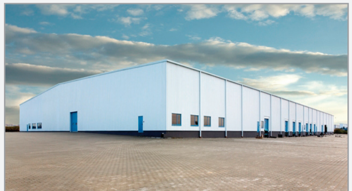
Budowniczy: Wielkopolskie Przedsiębiorstwo Inżynierii Przemysłowej, Polska Klient: Lena Lighting S.A. Architekt: Józef Kaczmarek
