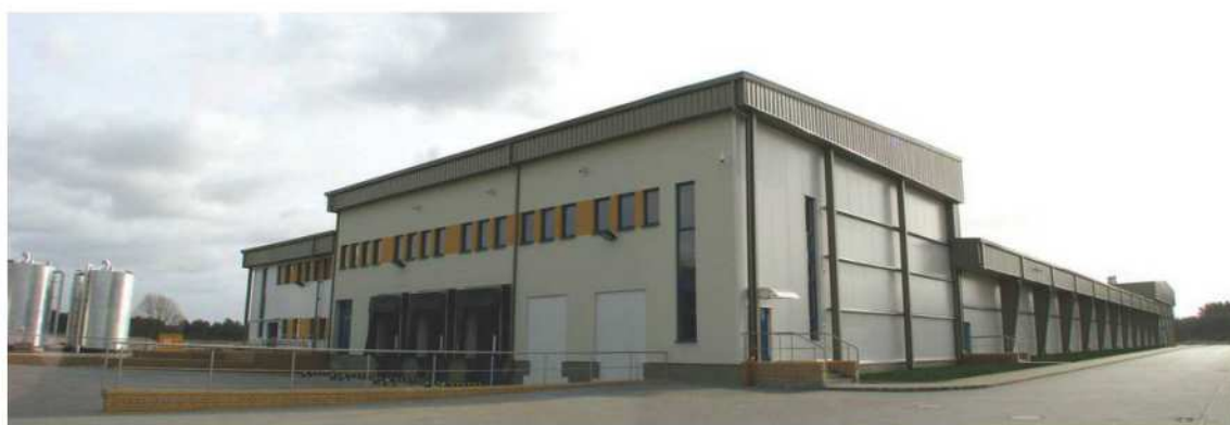
Obiekt o powierzchni 7912m 2 składa się z zakładu produkcyjnego, chłodni i zaplecza biurowo-socjalnego.
